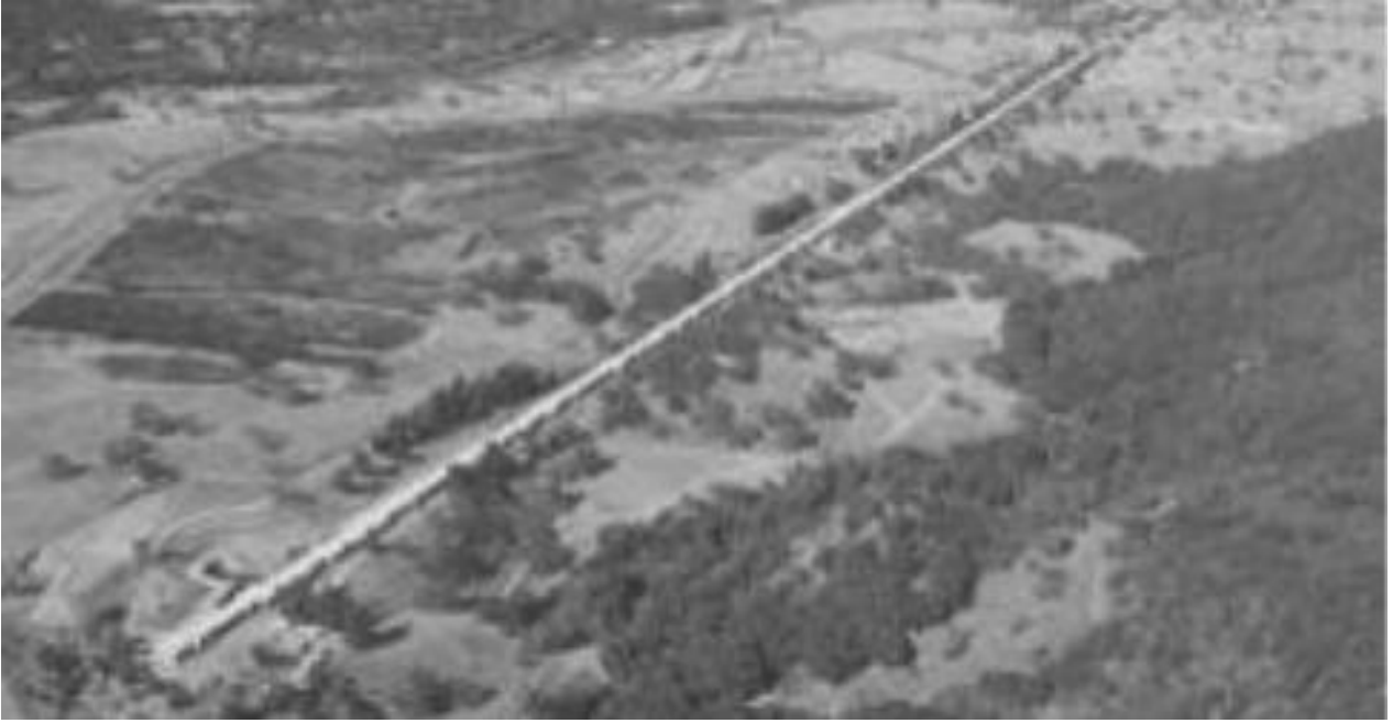
Fig. 14 L'accélérateur linéaire de 3 km de long du Stanford Linear Accelerator Center (SLAC). Les électrons partent d'un « canon » de l'accélérateur où ils sont libérés par un filament chauffé à l'extrémité de la machine, en bas à gauche de l'image. Les électrons surfent alors sur des ondes radio installées dans une chaîne de 100 000 « cavités » cylindriques en cuivre, d'un diamètre d'environ 12 cm. La machine est alignée à 0,5 mm près sur toute sa longueur et se trouve dans un tunnel à 8 m sous terre. Les bâtiments de surface qui délimitent la ligne du linac contiennent les klystrons qui fournissent les ondes radio.
