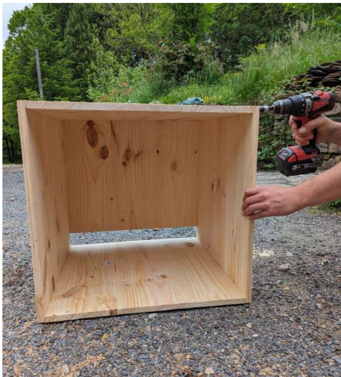
Une fois assemblé, le caisson forme une boîte compacte de 60 cm de côté.
